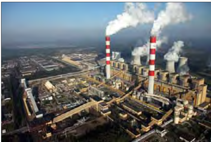
Электрастанцыя ў Бэлхатаве – найбуйнейшая цеплавая электрастанцыя ў Еўропе.
